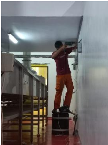
Gambar 1. Pemasangan perangkat monitoring suhu di TeFa Canning
