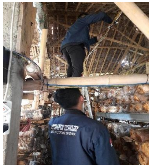
Gambar 5. Pemasangan selang dan nozzle pengembunan kumbung jamur
