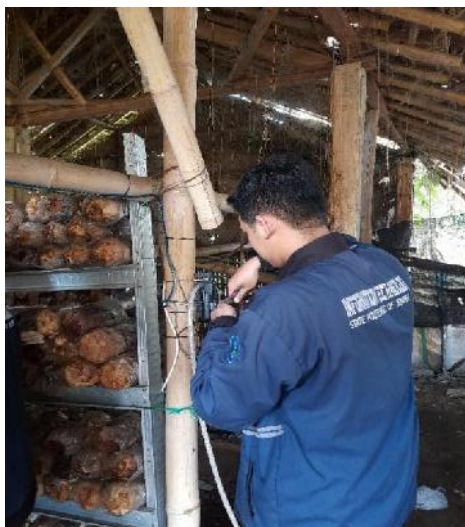
Gambar 4. Pemasangan alat kontrol suhu
