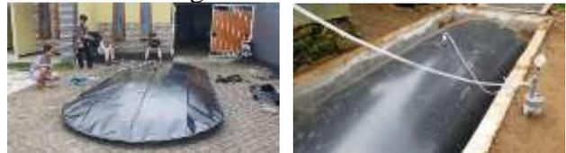
Gambar 10. Pembuatan dan instalasi digester balon pada mitra
