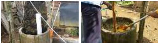
Gambar 9. Konstruksi bak penampungan slurry dan saluran inlet pada mitra
