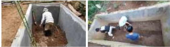
Gambar 8. Pembangunan konstruksi dasar dari lubang digester balon
