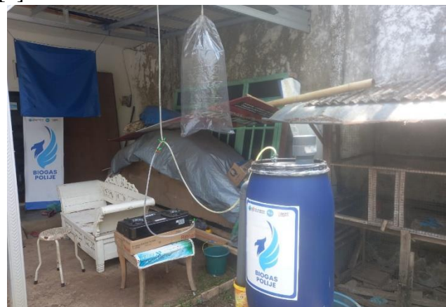
Gambar 3. Pemasangan disgester dan plastic penampung biogas yang telah disusun beserta limbah kotoran ternak.
