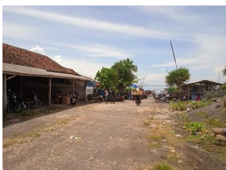
Gambar 2. Lokasi penempatan panel surya
