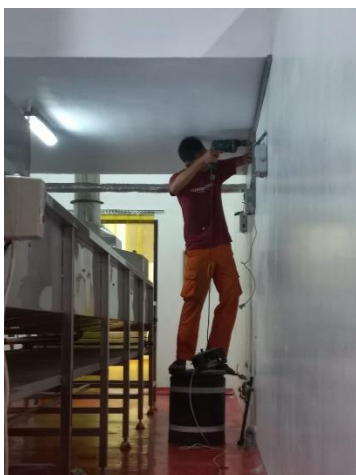
Gambar 1. Pemasangan perangkat monitoring suhu di TeFa Canning
