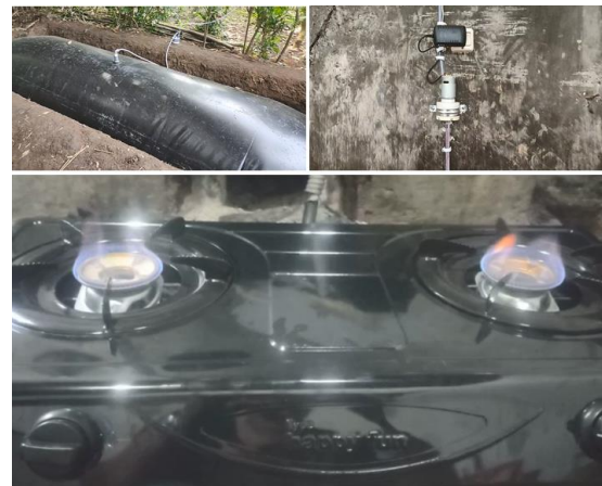
Gambar 7. Instalasi saluran biogas pada mitra
