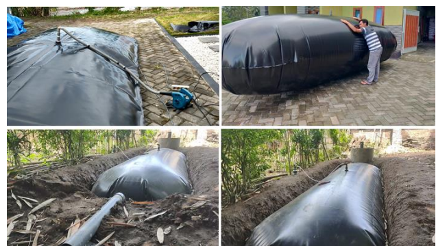
Gambar 5. Instalasi digester balon pada mitra
