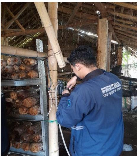
Gambar 4. Pemasangan alat kontrol suhu
