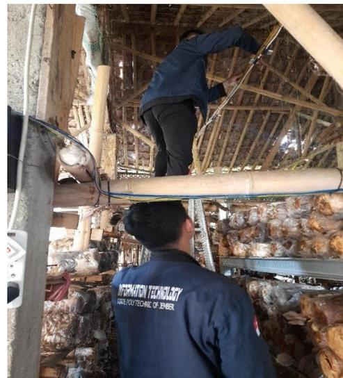
Gambar 5. Pemasangan selang dan nozzle pengembunan kumbung jamur
